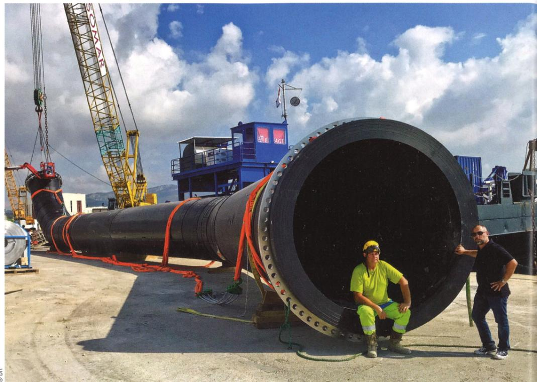
Pour ces travaux, un record d'Europe est établi avec la pose sous-marine de tuyaux en PEHD de Ø 2 500 mm de diamètre. Les tronçons sont reliés entre eux par boulonnage.
