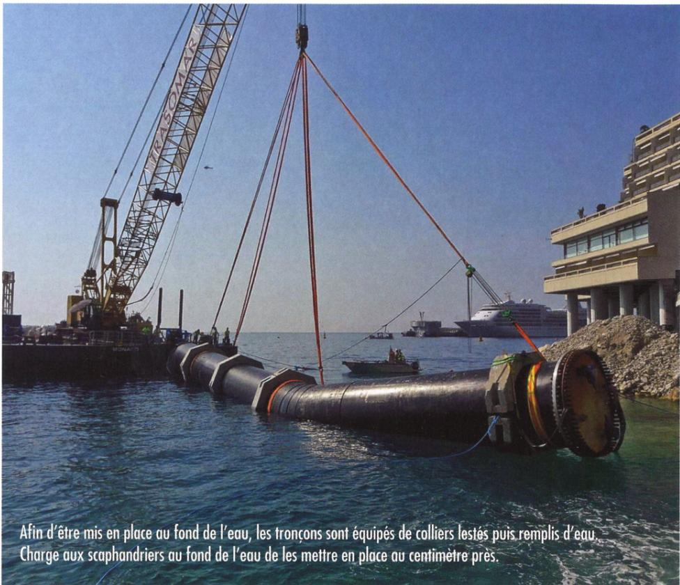
Afin d'être mis en place au fond de l'eau, les tronçons sont équipés de colliers lestés puis remplis d'eau. Charge aux scaphandriers au fond de l'eau de les mettre en place au centimètre près.
