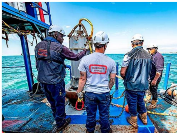
Au cours d'un chantier d'installation de géotubes.
