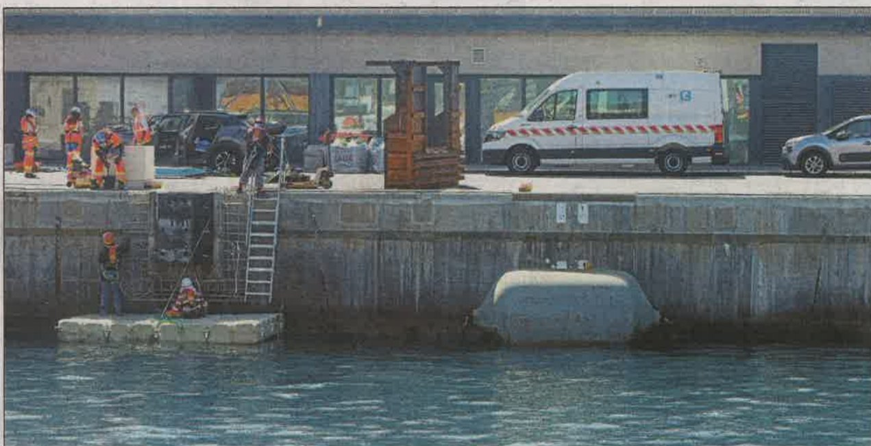
Sur les aménagements d'alimentation du quai, des travaux sont réalisés par l'entreprise Sade Monaco au niveau des défenses d'accostage destinées à tenir les navires éloignés du quai. « On triple leur surface pour qu'elles soient mieux adaptées à l'accueil des méga-yachts », explique Olivier
