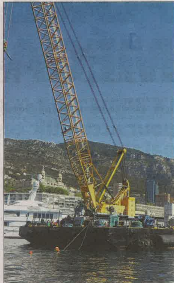
Ces travaux d'envergure nécessitent le concours d'une barge de travail de 60 mètres de long et de 22 m de large, dont le planning d'interventions a été établi en fonction de celui des croisières. Hier, la barge a procédé à des manœuvres afin de pouvoir installer le quatrième et dernier corps-mort (au pied du fort Antoine) prévu pour cet aménagement. Celui-ci sera assemblé d'ici demain.
