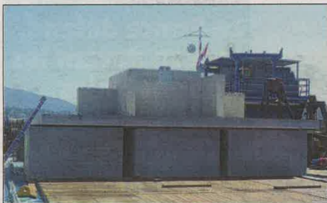
En face de la digue, les travaux de mouillage consistent en la mise en place de quatre corps-morts de près de 250 tonnes, composés d'un châssis (environ 45 T) et de six lests (36 T l'un) chacun. Disposés parallèlement au quai à 50 mètres de profondeur, ces systèmes seront pourvus de chaînes, reliées à des bouées immergées à 15 mètres de profondeur sur lesquelles viendront s'amarrer les yachts. L'opération nécessitera l'intervention de plongeurs lors des manœuvres d'amarrage.
